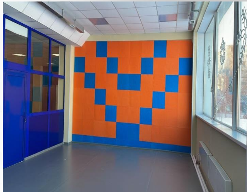
СК «Снежинка» ремонт помещений центра тестирования «Стань чемпионом»
